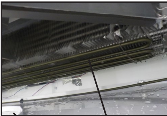
Defrost Heater Fan Plenum; Heater
