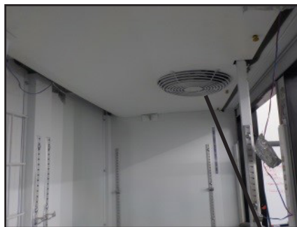
Remove Fan Plenum
