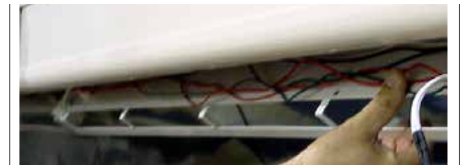
Accès aux ballasts des tablettes et du pavillon
