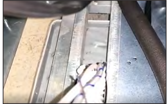
Vista superior de la tubería de drenaje
