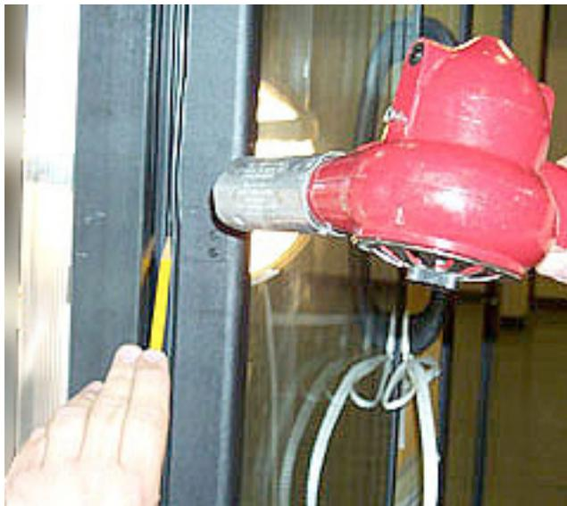
Tirer le joint pour le mettre en place avec un crayon
