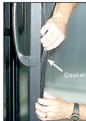
Remove Door Gasket
