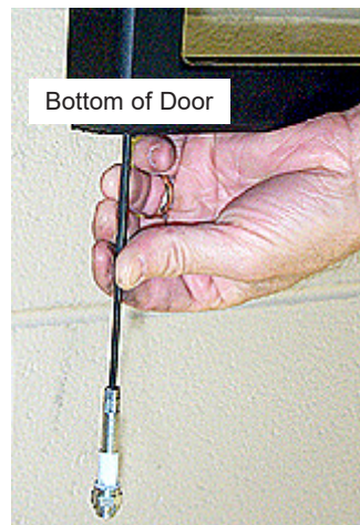
Replace Door Hinge Spring
