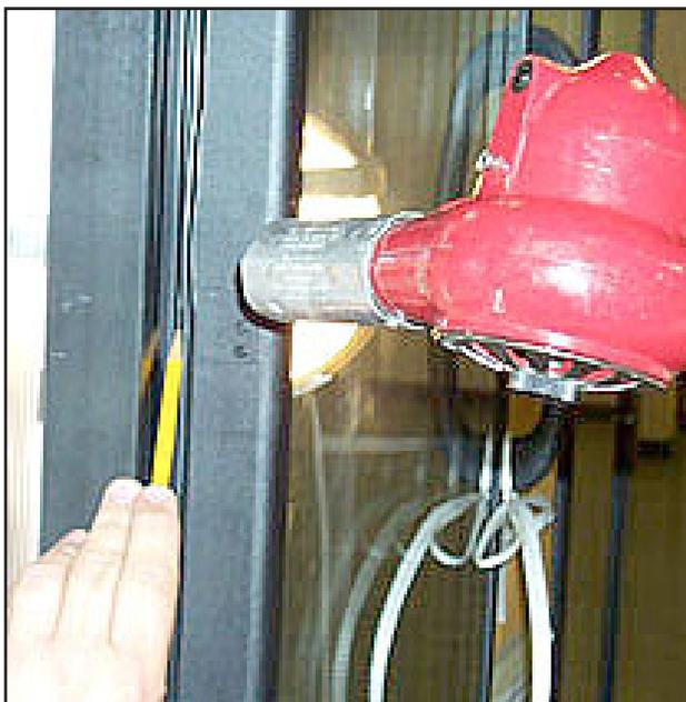
Tirer le joint pour le mettre en place avec un crayon
