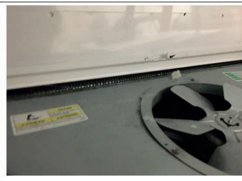
Incorrecto - el serpentín del evaporador se puede ver entre el panel posterior y el pleno del ventilador
