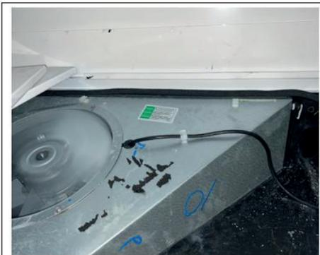
Correcto - el sello está entre la parte inferior del panel posterior y la parte superior del pleno del ventilador
