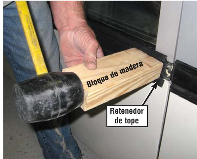
Para los exhibidores con retenedores de goma y frentes de vidrio, reemplace el retenedor como se muestra a continuación usando un bloque de trozo de madera y un martillo de goma. Una persona debe sujetar el retenedor para mantenerlo alineado mientras otra le da golpes suaves para colocarlo en su lugar.
