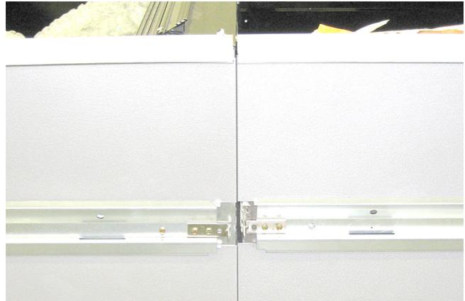
Añada calzas a los exhibidores para asegurar la alineación vertical de los paneles y los rieles superiores.
