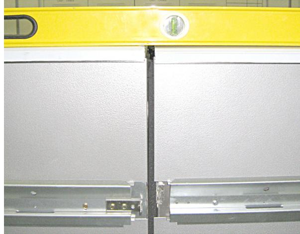
Añada calzas a los exhibidores para asegurar la alineación vertical de los paneles y los rieles superiores.
