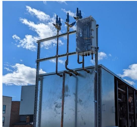
3. À l'aide d'Unistrut ou d'un matériau équivalent, construisez un assemblage pour supporter le poids des détendeurs. Dans la planification de la construction, veuillez prévoir l'application de forces supplémentaires pendant l'évacuation de gaz pressurisé.
