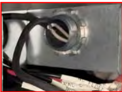
(Étape 2) Passez les fils à travers le conduit.
