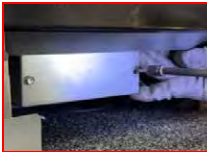
(Étape 1) Retirez le couvercle de la boîte de jonction électrique.
