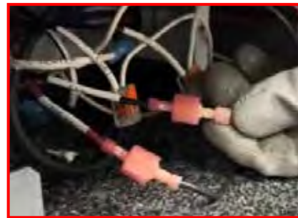
(Étape 3) Connexion de la plinthe du ventilateur
