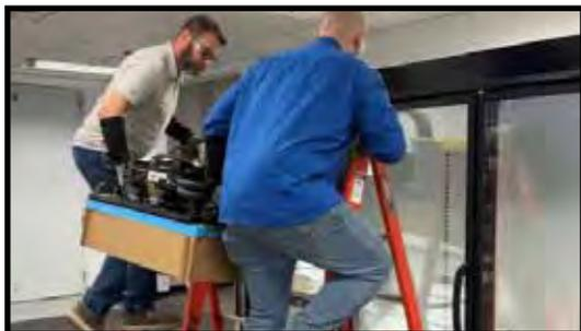
Coloque la unidad en la parte superior del exhibidor y, a continuación, retire las bandas de sujeción (4) de las esquinas y el cartón protector alrededor del evaporador.
