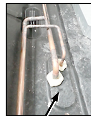
Salida de la tubería
