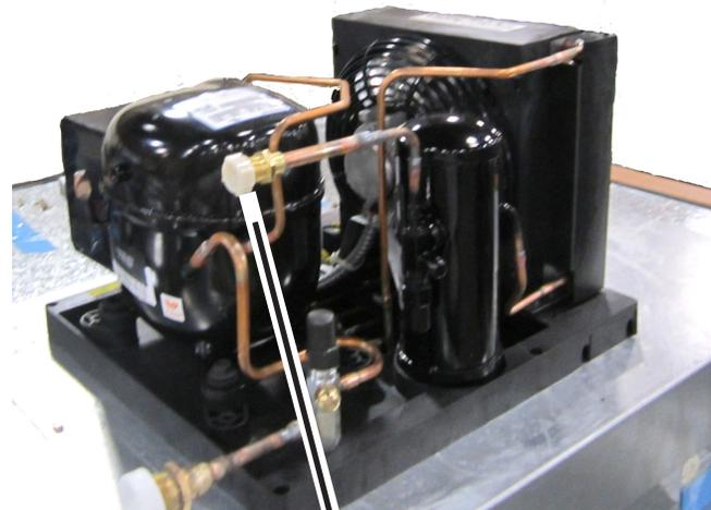
Conexión rápida de salida
