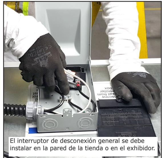
El interruptor de desconexión general se debe instalar en la pared de la tienda o en el exhibidor.
