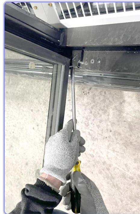
Utilice un destornillador para quitar la cubierta de la placa de torsión, como se muestra. La placa se desliza hacia la derecha, alejándola de la puerta.
