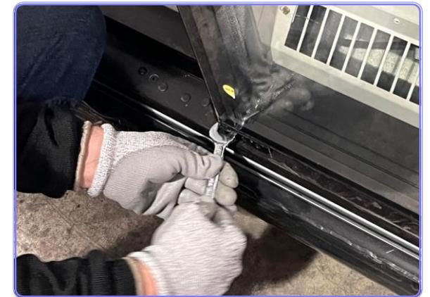
Deslice el perno de torsión hacia arriba y hasta el perno del marco.
