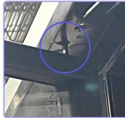
Deslice el perno de torsión hacia arriba y sobre el pasador del marco.
