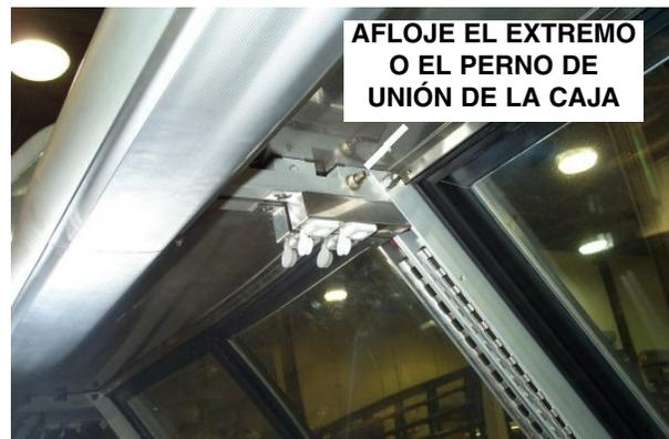
1. Afloje los pernos de unión o de extremo en la parte superior del exhibidor (2 en cada extremo del exhibidor).
