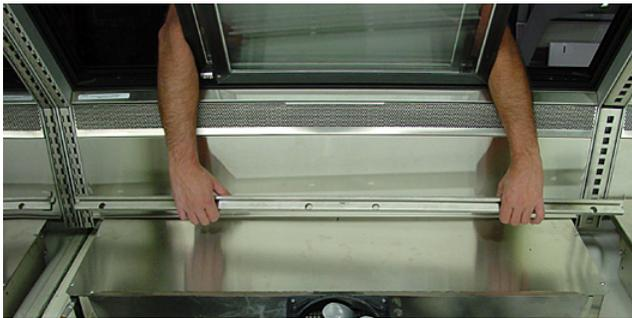
**PASO 7 – Levante la rejilla de aire de descarga.**
