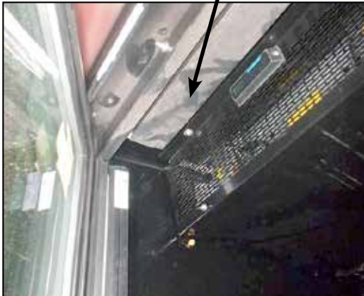
Ubicación de fuente de alimentación o balastra de 1 puerta - detrás del marco superior
