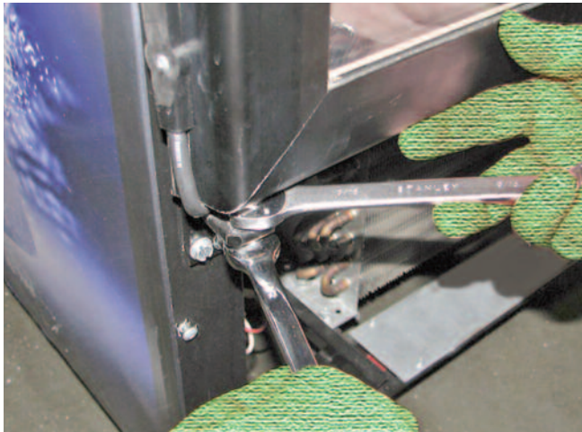
Ajuste la torsión para que cierre la puerta
