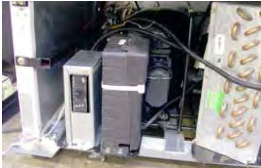
Ubicación del controlador Safe-Net III
