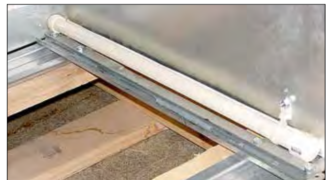
Tubería de desagüe auxiliar
