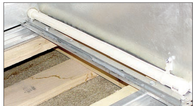
Ligne d'évacuation auxiliaire
