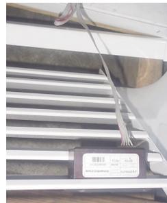
La pantalla de Safe-NET III se monta sobre el lado izquierdo del panel de acceso. Tenga cuidado de no desprender el cable Safe-NET III del exhibidor cuando quite el panel de acceso.
