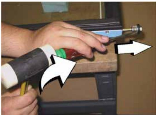
15. Transférez l'axe de charnière et la tige de torsion dans l'autre trou de montage dans le rail côté charnières de la porte.
