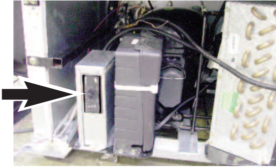
Ubicación del controlador Safe-NET III
