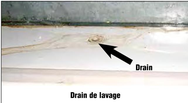
Le drain de lavage est relié à une conduite vidange auxiliaire.
