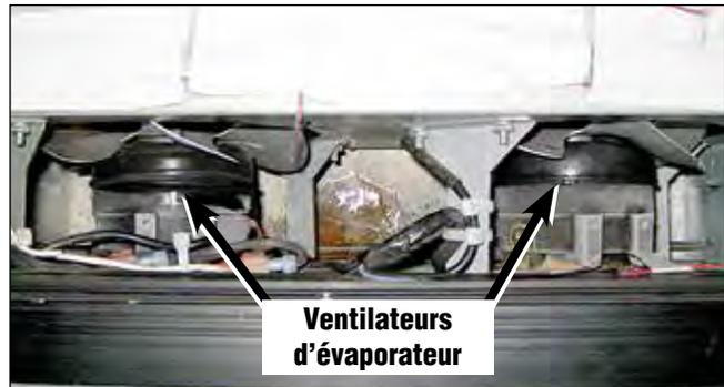
Remarque : Pour réduire l'accumulation de givre sur le serpentin de l'évaporateur, les ventilateurs s'arrêteront lors de chaque ouverture de porte et se remettront en marche lorsque la porte se ferme.
