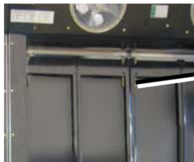
Detalle — Jale los pernos para liberar las puertas del riel
