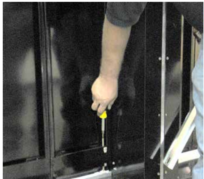
Use un destornillador para ajustar verticalmente
