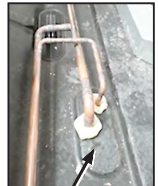
Salida de la tubería
