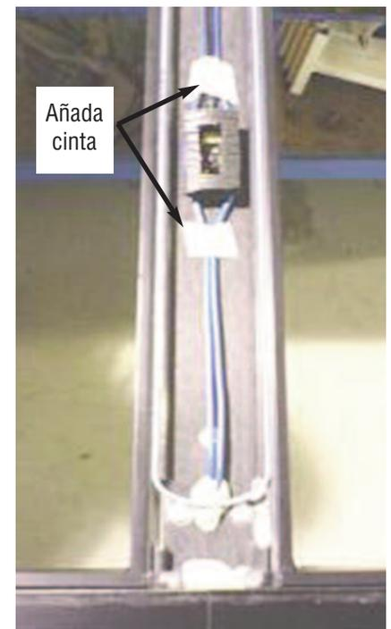
6. Encamine el cableado del arnés en el montante con el marco superior y luego dentro del marco superior al paso de cables.
