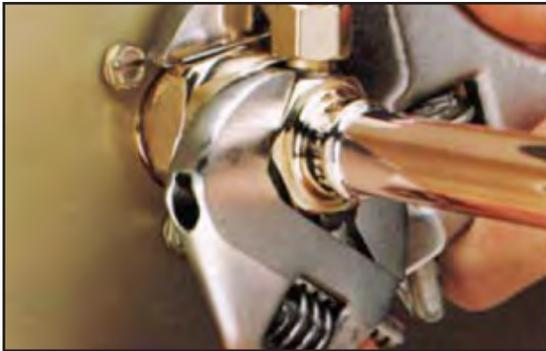
**CORRECTLY TIGHTENED COUPLING**
