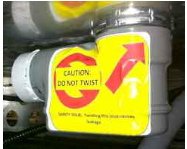
Sello de agua y tubería de RI / SI
