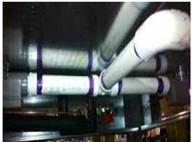
Tubería de RI / SI con un drenaje (ambos lados)
