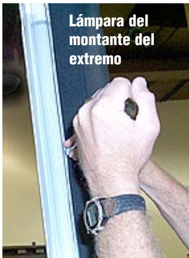
Retire el difusor de la lámpara del montante del extremo
