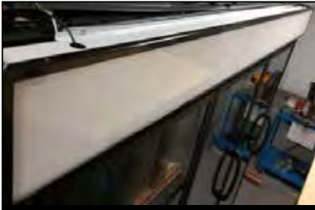
L'afficheur se glisse pour donner accès au chemin de câbles
