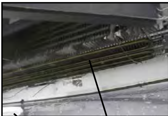
Plénum de ventilateur; élément chauffant Élément chauffant de dégivrage
