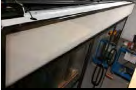
La pantalla se desliza hacia fuera para tener acceso al paso de cables
