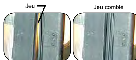
Avant et après le conditionnement du joint
