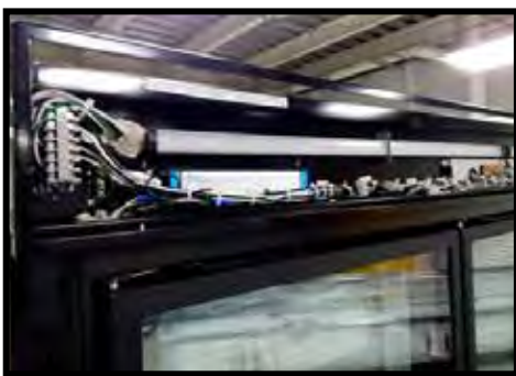
DEL et bloc d'alimentation illustrés avec le panneau d'afficheur retiré.
