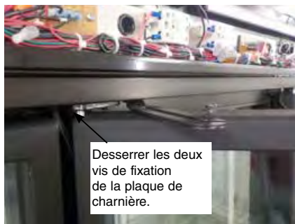
Réglage de l'alignement des portes
