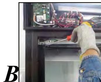
Il est maintenant possible de remplacer les éléments chauffants de cadre de porte.
