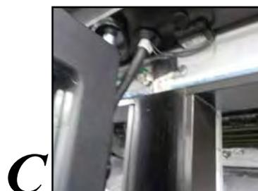
Une fois le câble de l'élément chauffant connecté, vérifier la résistance (valeur en ohms) avant de remettre en place les couvercles du chemin de câble. Ceci garantit que le câble de l'élément chauffant n'est pas endommagé pendant l'installation. Les schémas de câblage sont montrés dans les dernières pages de ce manuel.
