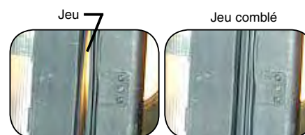
Avant et après le conditionnement du joint
