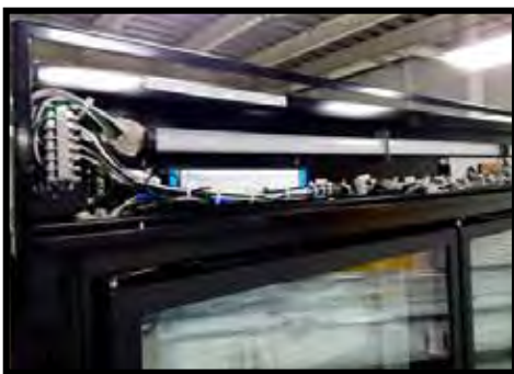
Lámpara LED y fuente de alimentación mostradas sin el panel de la pantalla
