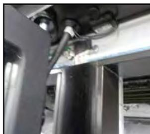
Una vez conectado el cable del calentador, verifique la resistencia (lectura de ohms) antes de volver a colocar las cubiertas del paso de cables. Esto asegurará que el cable del calentador no se haya roto durante la instalación. En las últimas páginas de este manual encontrará los diagramas de cableado.
