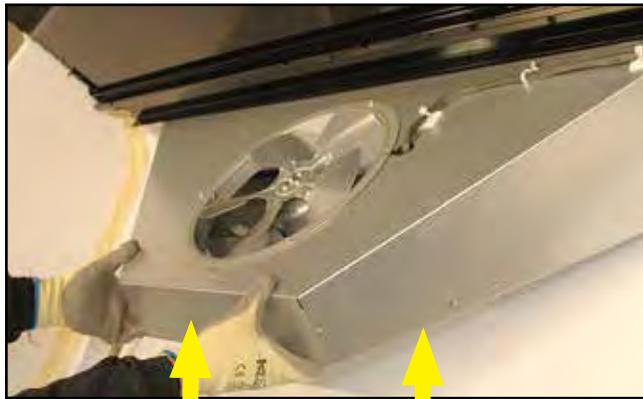
Levante el pleno del ventilador. Use la cadena para enganchar el pleno del ventilador y facilitar la limpieza (para cuñas interiores).
