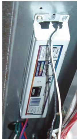
6. Localice y retire las balastras. Monte las fuentes de alimentación de las lámparas LED en el toldo. La fuente de alimentación tiene una entrada de 120 V-50/60 Hz y una salida de 24 V CC.
