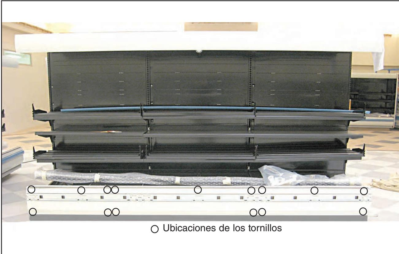
Para corregir la alineación vertical de los rieles superiores y del panel delantero superior, ajuste las calzas según sea necesario.
