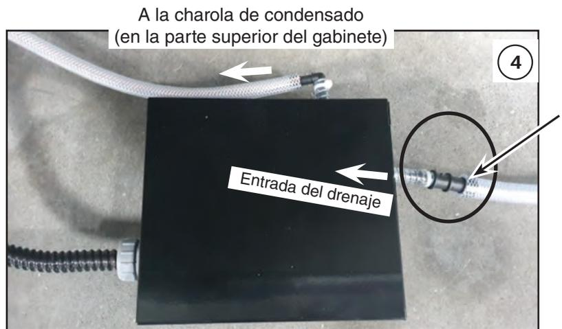
Asegúrese de introducir la tubería de drenaje en el acoplamiento de manera completa y correcta.
