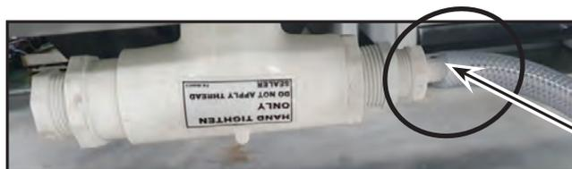
(Manguera de drenaje no introducida completamente)
