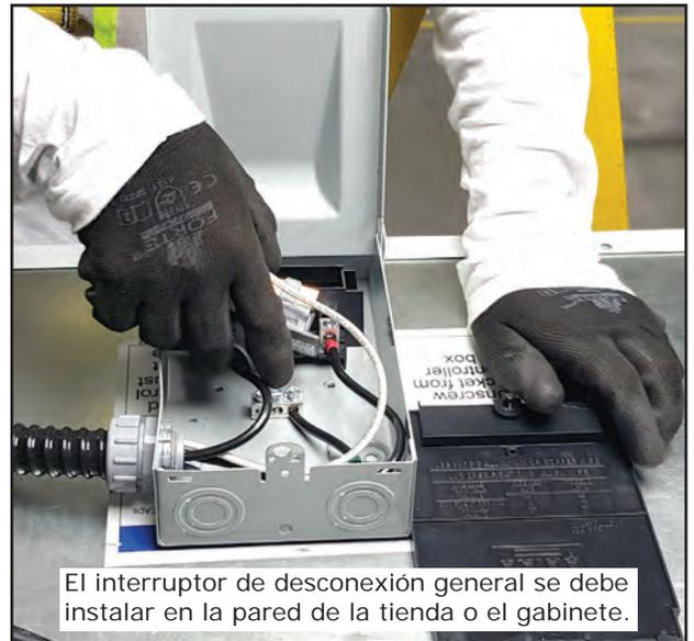
El interruptor de desconexión general se debe instalar en la pared de la tienda o el gabinete.
