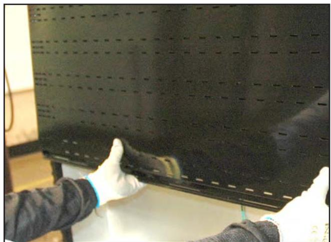
5. Vuelva a colocar los paneles en orden inverso, empezando con el panel superior.
