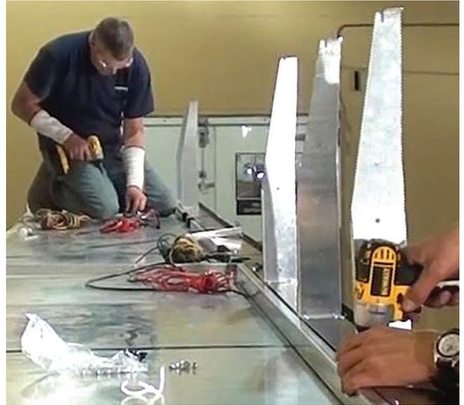
**Instale los apoyos de la fachada con los orificios proporcionados**
