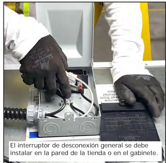
El interruptor de desconexión general se debe instalar en la pared de la tienda o en el gabinete.
