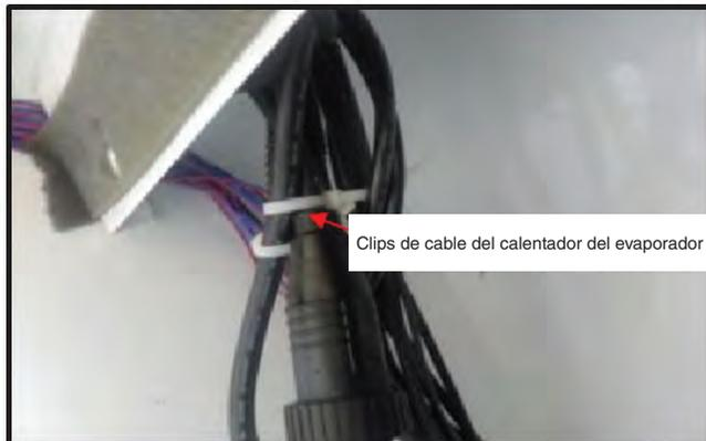
5. Tire del cable del calentador desde el interior. (Calentador de la charola de goteo o calentador del evaporador Evaporador)
