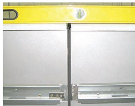
4. Alinee los sujetadores del marco. Ensamble sin apretar el perno, las arandelas, la arandela de seguridad y la tuerca, como se muestra aquí.
