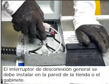
El interruptor de desconexión general se debe instalar en la pared de la tienda o el gabinete.
