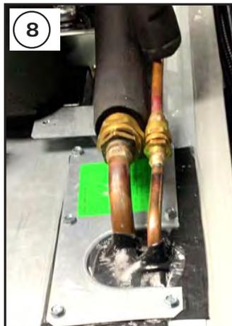
9. Use el aislamiento previamente cortado en tiras en el tubo de 5/8 pulg., y en el tubo de 3/8 pulg. use el aislamiento ya colocado en la unidad condensadora.
