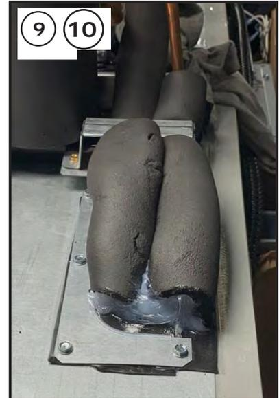
10. Coloque sellador de silicona alrededor de la tubería.
