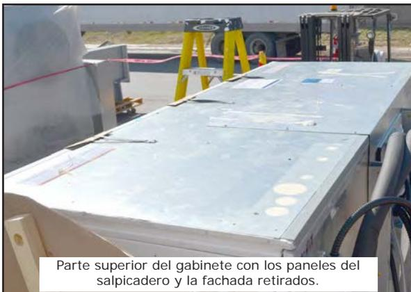
Parte superior del gabinete con los paneles del salpicadero y la fachada retirados.
