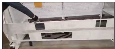
Charola de condensado (instalada en la parte superior del gabinete)
