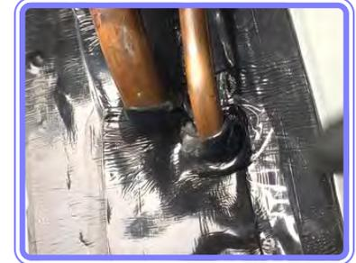
3. Vuelva a colocar la cubierta protectora. Tenga cuidado para asegurarse de que la cubierta protectora no entre en contacto con la tubería.
