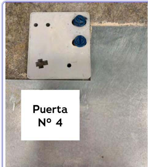
Instale los tornillos Tapcon de 1/4 pulg. (dos tornillos por placa). No apriete hasta que las puertas estén instaladas y ajustadas.
